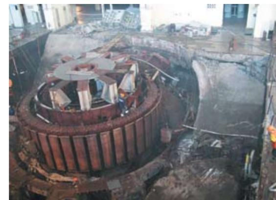
**Рис. 5.** Разрушение плиты перекрытия на отм. 327 м и «бочки» ГА-7
