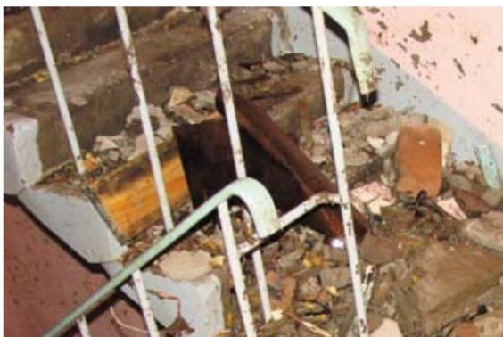
Рис. 9. Повреждения лестничных маршей под воздействием мощного водного потока, содержащего обломки строительных конструкций и сорванного оборудования
