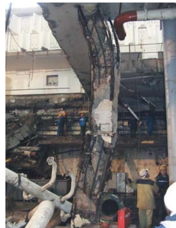
**Рис. 4.** ГА-8. Разрушенная колонна К1
