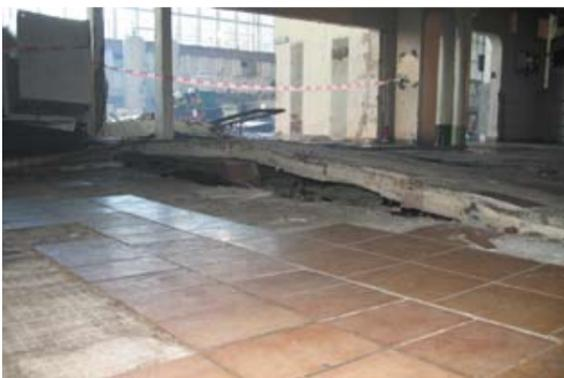
Рис. 7. ГА-7. Разрушение керамической напольной плитки по бетонной стяжке на отм. 327 м
