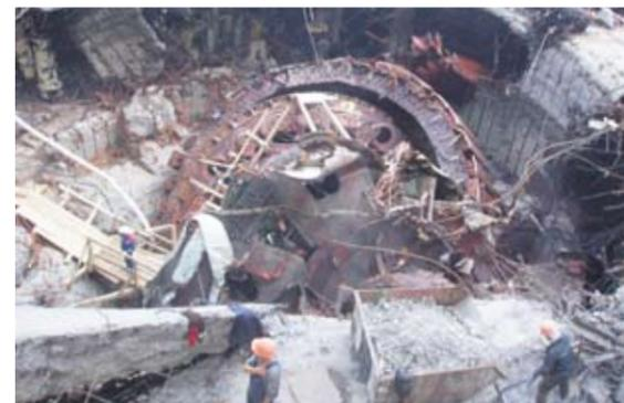
**Рис. 2.** Ударно-динамические воздействия при разгоне и подъеме ГА-2 привели к разрушению «бочки» генератора, фундаментов ротора и статора, плит перекрытия на отм. 327 м
