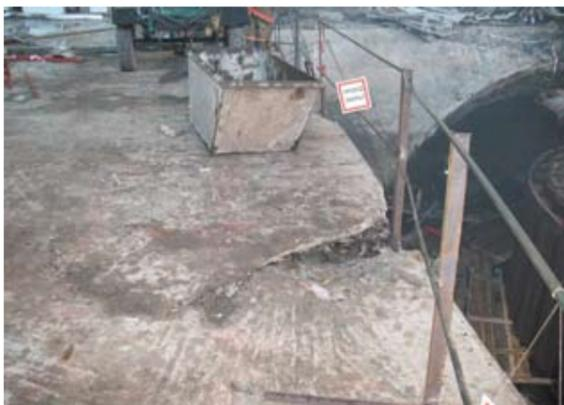
Рис. 8. ГА-8. Трещина в плите перекрытия
