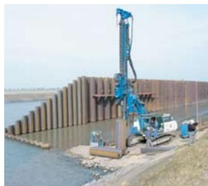
Фото 1. Самоходная установка с вибропогружателем TM 12/15. Порт Эммельзум, Германия
