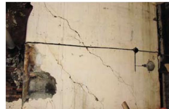
**Рис. 3.** ГА-2. Образование серии субгоризонтальных и наклонных трещин раскрытием от 1 до 7 мм в колонне КГ1 в отм. 319,8–327,0 м (вид со стороны ГА-1)
