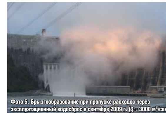
Фото 5. Брызгообразование при пропуске расходов через эксплуатационный водосброс в сентябре 2009 г. ( $Q \approx 3000$  м³/сек)
