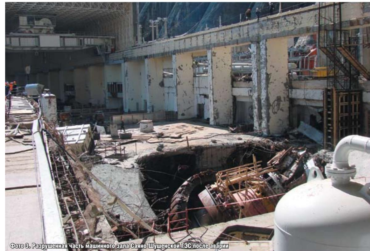
Фото 3. Разрушенная часть машинного зала Саяно-Шушенской ГЭС после аварии
