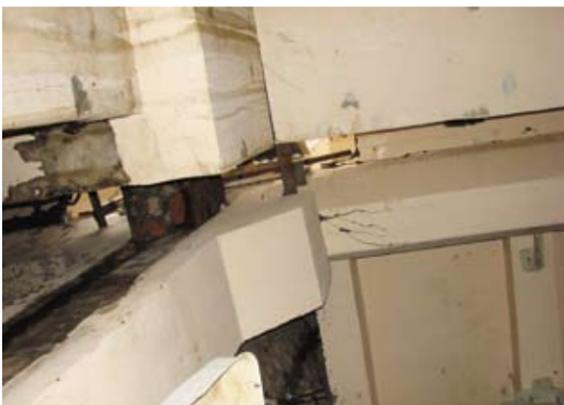
Рис. 6. ГА-2. Трещины и разрушения сборных железобетонных конструкций помещений в отм. 320-327 м
