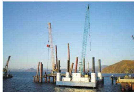
Фото 5. Самоподъемная гидравлическая платформа RCP-450. Порт «Козьмино», г. Находка
