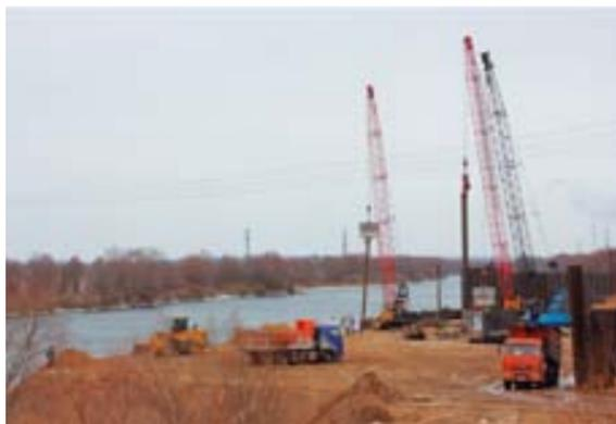
**Рис. 1.** Собственный парк строительной техники для проведения шпунтовых работ
