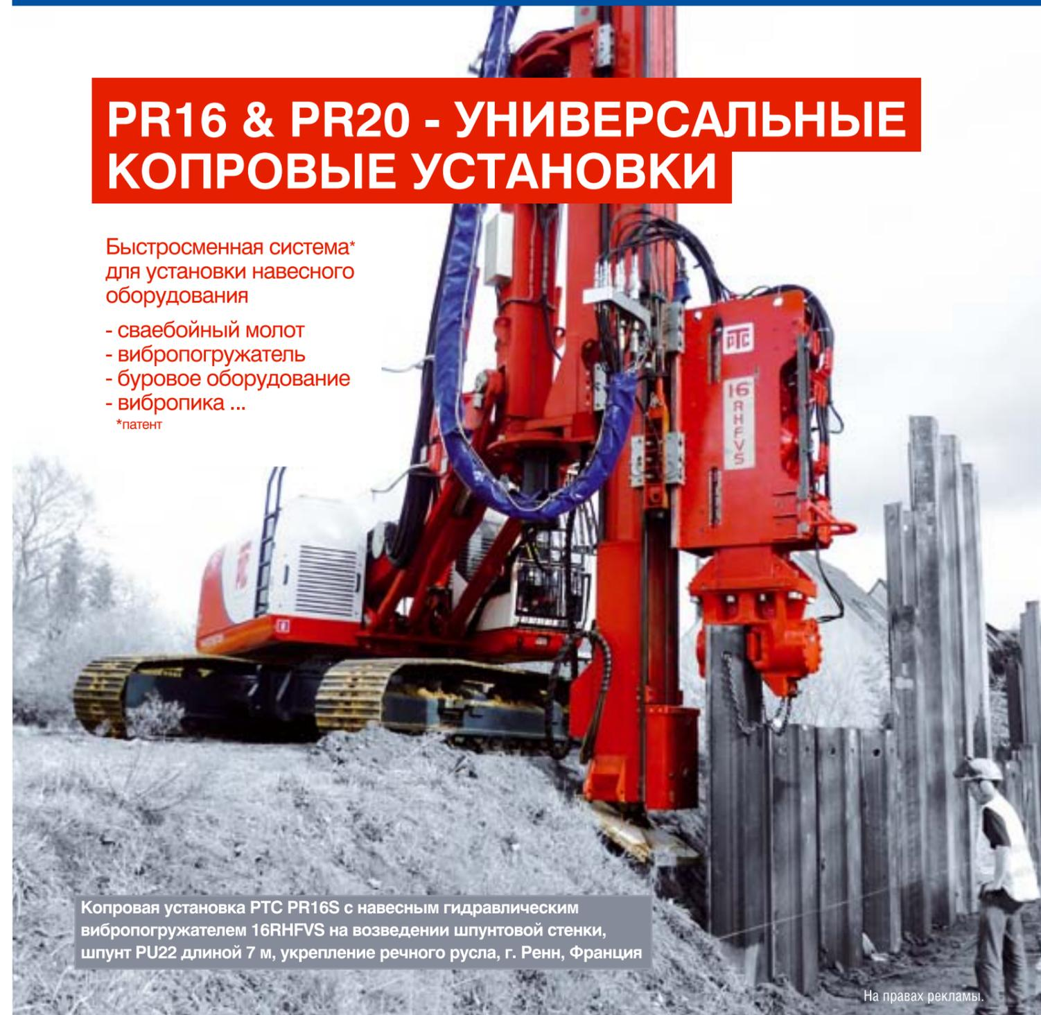
Копровая установка PTC PR16S с навесным гидравлическим вибропогружателем 16RHFVS на возведении шпунтовой стенки, шпунт PU22 длиной 7 м, укрепление речного русла, г. Ренн, Франция
