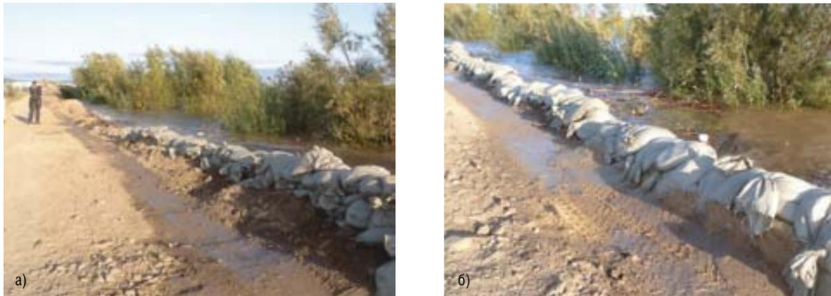
Рис. 6. Способ подъема гребня дамбы инженерной защиты, используемый при наводнении на р. Амур в 2013 г.: а — качество укладки мешков с песком; б — протечки воды через устройство временной защиты
