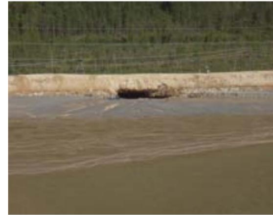
**Рис. 2. Вид придамбового участка хвостохранилища после ухода воды в образовавшийся в дамбе проран, возникший после оттайки высокольдистых пород, заложенных в тело дамбы**
