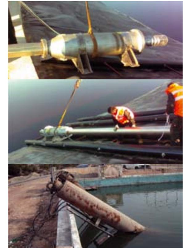
Рис. 14. Наклонное размещение высоконапорных насосов Indar в лиманах и нижних отметках затопленных территорий. На откосы дамб устраиваются рельсы для упрощенной установки насосов в рабочее положение
