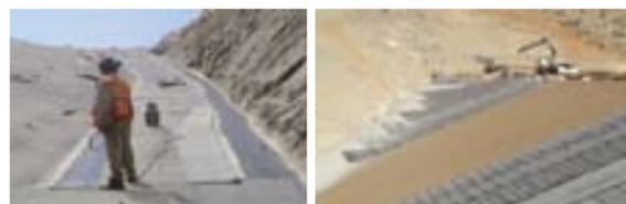
Фото 3. Детали системы экрана из БГМ
