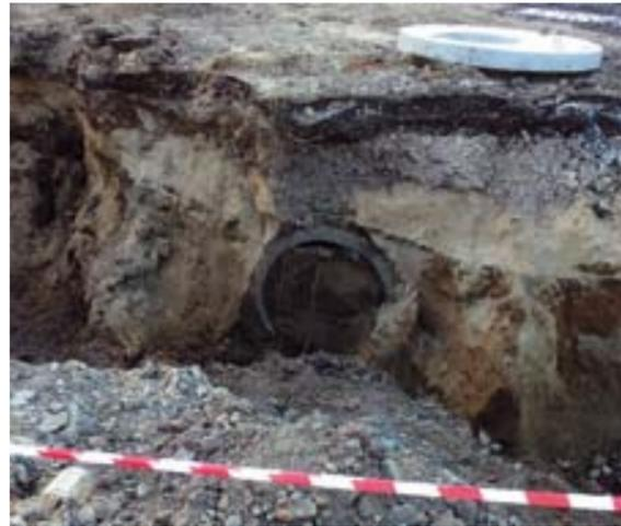
Рис. 10. Сеть крупного ливневого коллектора буквально забита отложениями до неработоспособного состояния
