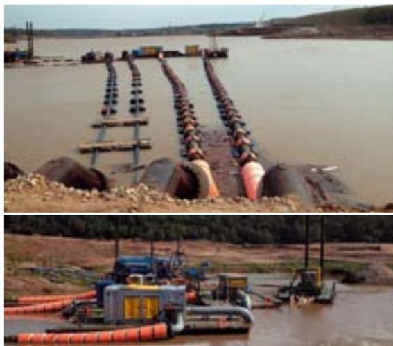
**Рис. 17.** Дизельные насосные агрегаты ВВА для регулирования уровня воды и предотвращения наводнений на Загорской ГАЭС
