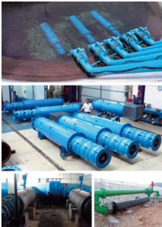
**Рис. 15.** а) Горизонтальное размещение высоконапорных насосов Indar в лиманах и нижних отметках затопленных территорий; б) погружные насосы Indar горизонтального исполнения; в) при использовании сложных схем перекачек и необходимости последовательной работы насосов вторая ступень монтируется в охлаждающей гильзе
